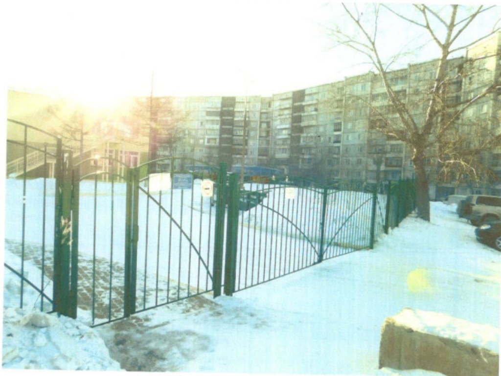
Территория, прилегающая к зданию Фото 1
